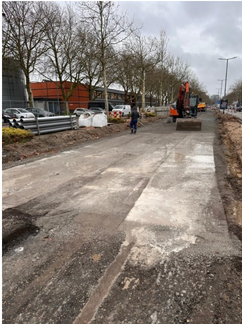
Asfalt verwijderd en nieuwe onderbaan geprofileerd
