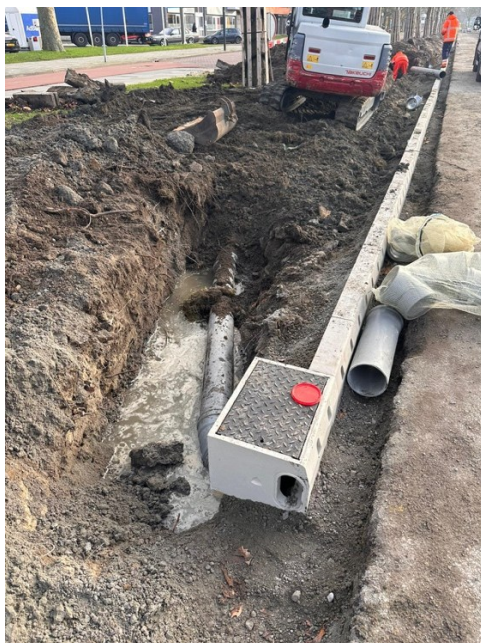
Akodrains geïnstalleerd en aangesloten op riool
